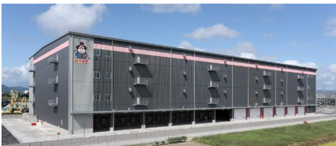
建物外観(南西面)
